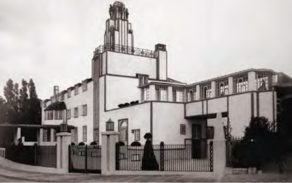
^ Й. Хоффман. Вид дворца Стокле в Брюсселе с угла. 1905–1911. Фото 1910-х гг.
