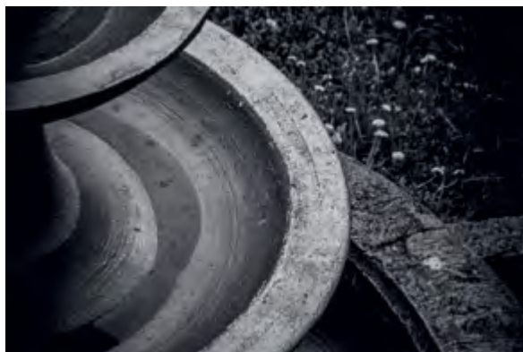
> Рис. 5. Кисловодск. Чаша фонтана в комплексе санатория НКТП. Архитектор Иван Леонидов. 1938
