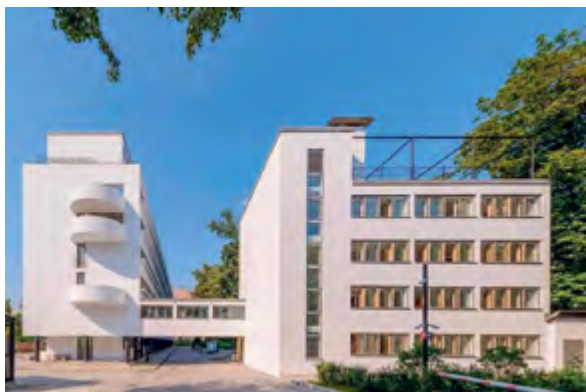
^ Рис. 1. Дом работников Наркомфина. Архитектор М. Я. Гинзбург. 1930. Фото Дмитрий Якубов. – URL: https://clck.ru/YHWi7
