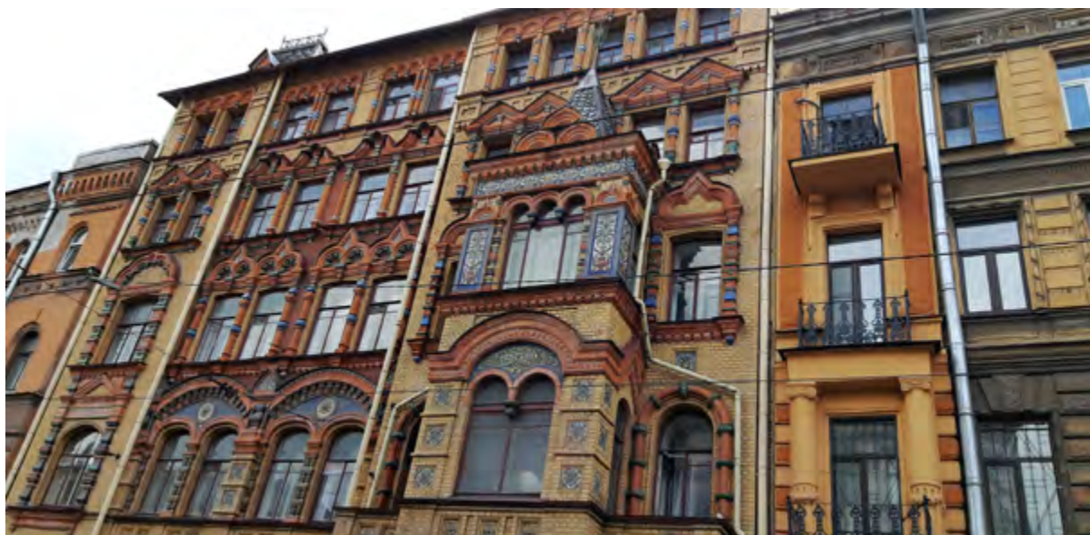
> Рис. 12. Собственный дом епархиального архитектора Н. Н. Никонова. Парадный фасад. Санкт-Петербург, Колокольная ул., 11. Фото А. Ивановой, август 2021
