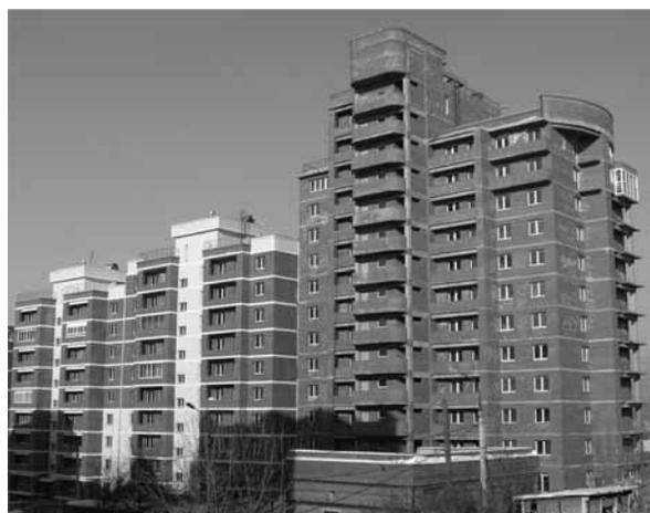
Жилые дома с железобетонным каркасом, диафрагмами жесткости и кирпичным заполнением
